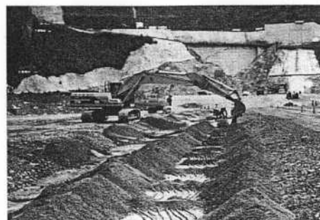
写真-2 ケーブルトレンチの施工状況
