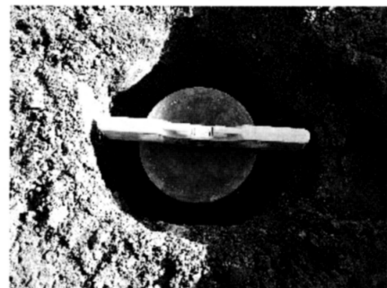
図-16 ワイヤレス間隙水圧計の孔への設置状況
