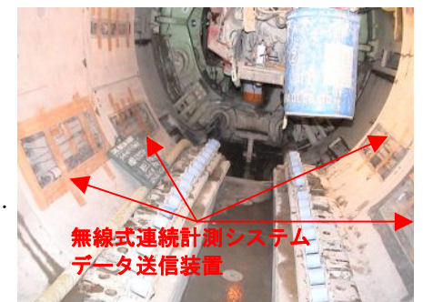
写真-2 セグメントの組立時計測
