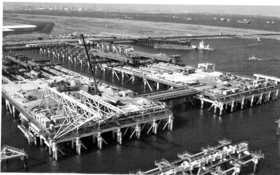
写真3 連絡誘導路栈橋部施工状況
