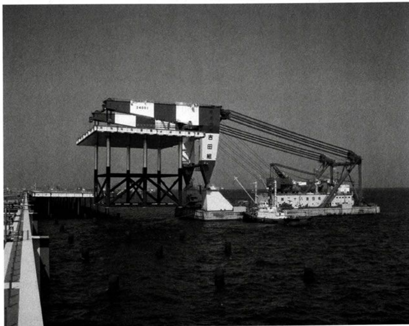
写真1 低頭起重機船によるジャケット 据付
